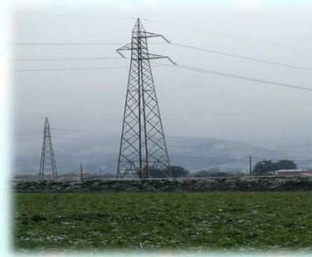
Linea di trasmissione ad alta tensione D \geq 5 metri
