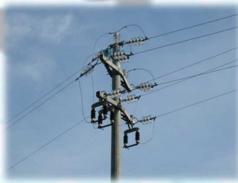
Linea media tensione in conduttori nudi D \geq 3,5 metri
