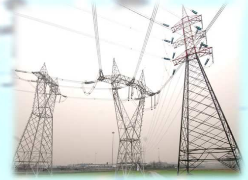
Linea di trasmissione ad altissima tensione D \geq 7 metri
