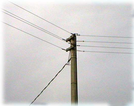
Linea bassa tensione in conduttori nudi D \geq 3 metri
